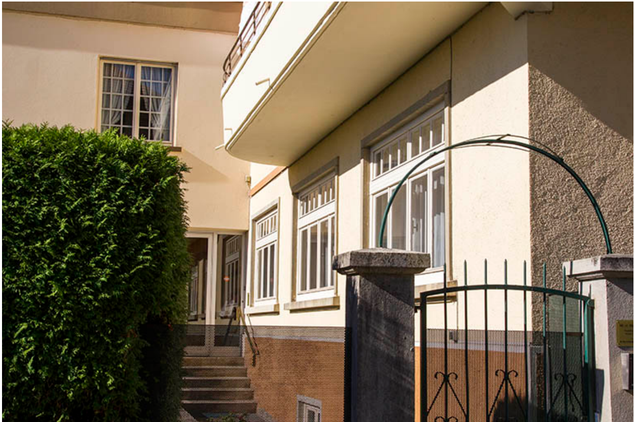
Façade postérieure : baies d'atelier.
