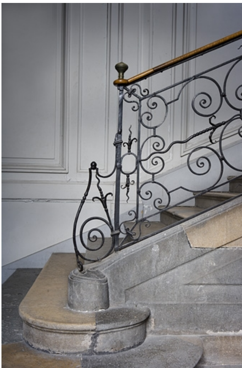
Détail du départ de l'escalier.
