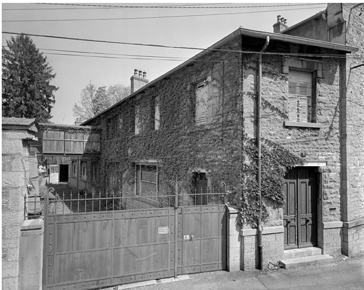
Elévation ouest depuis la rue.
