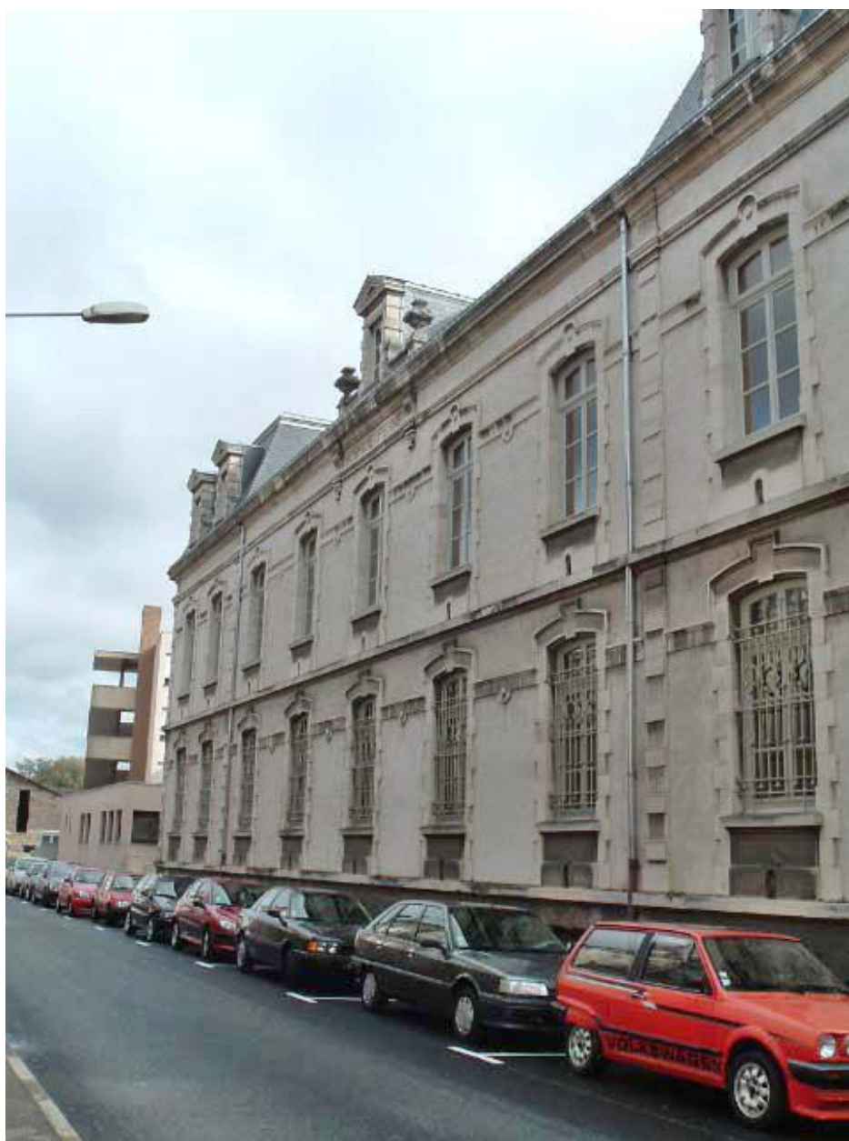
Vue générale latérale de la façade postérieure.
