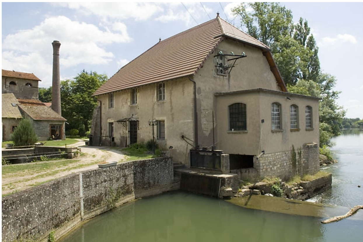
Moulin reconverti en centrale hydroélectrique.
