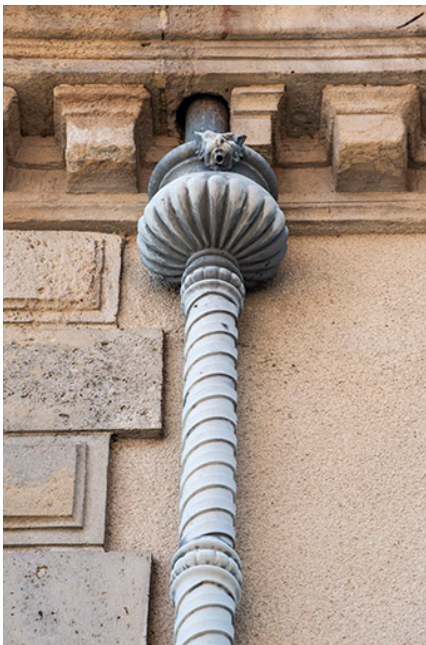
Descente d'eau en hélice avec cuvette godronnée.
