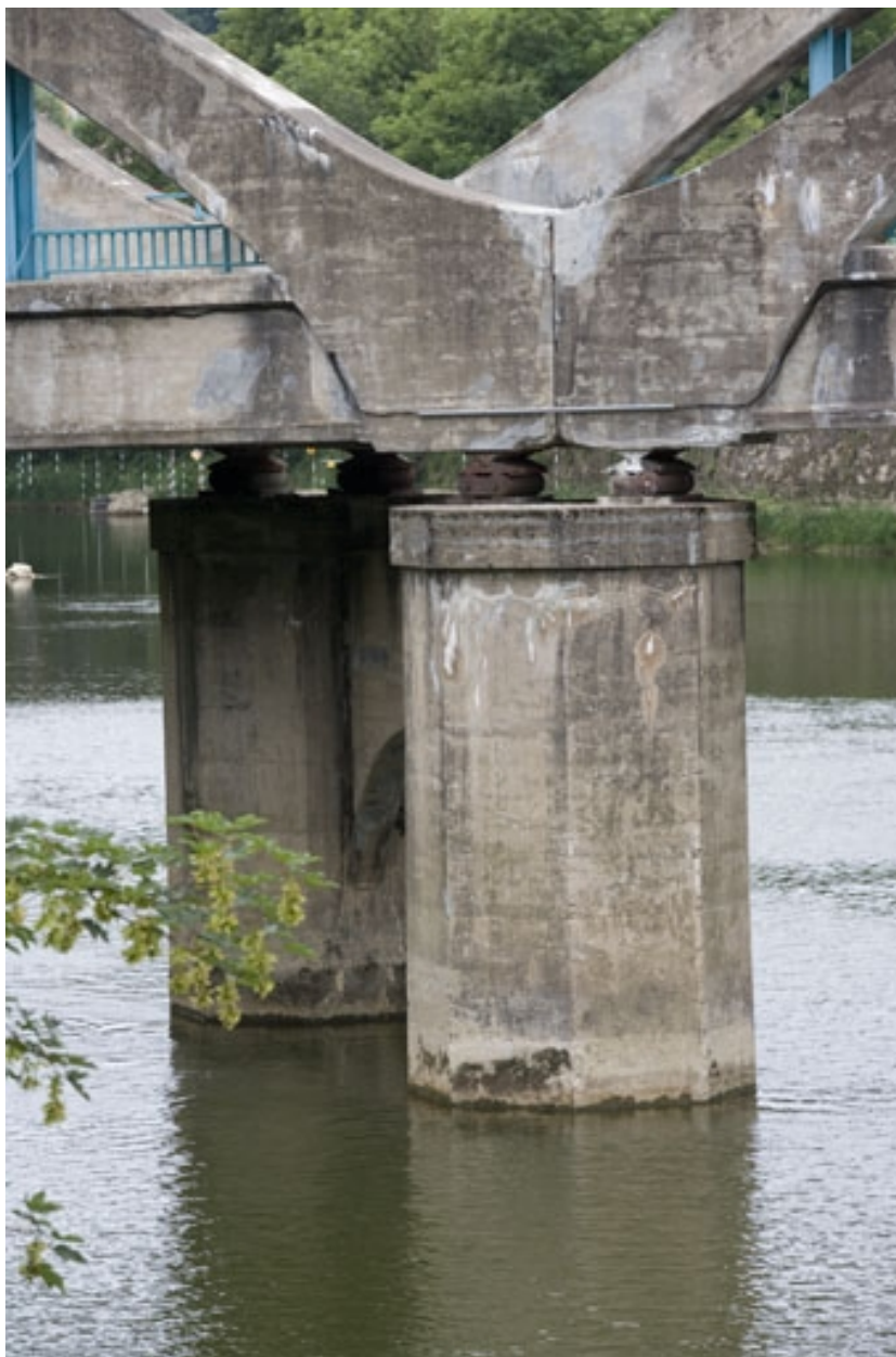
Piles côté rive gauche.
