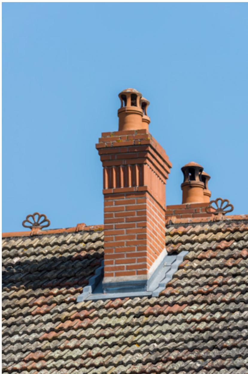
Hôtel-restaurant : souches de cheminée.
