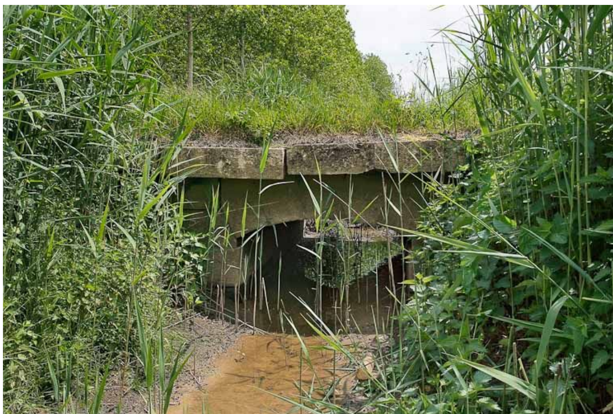
Ponceau, vue rapprochée.
