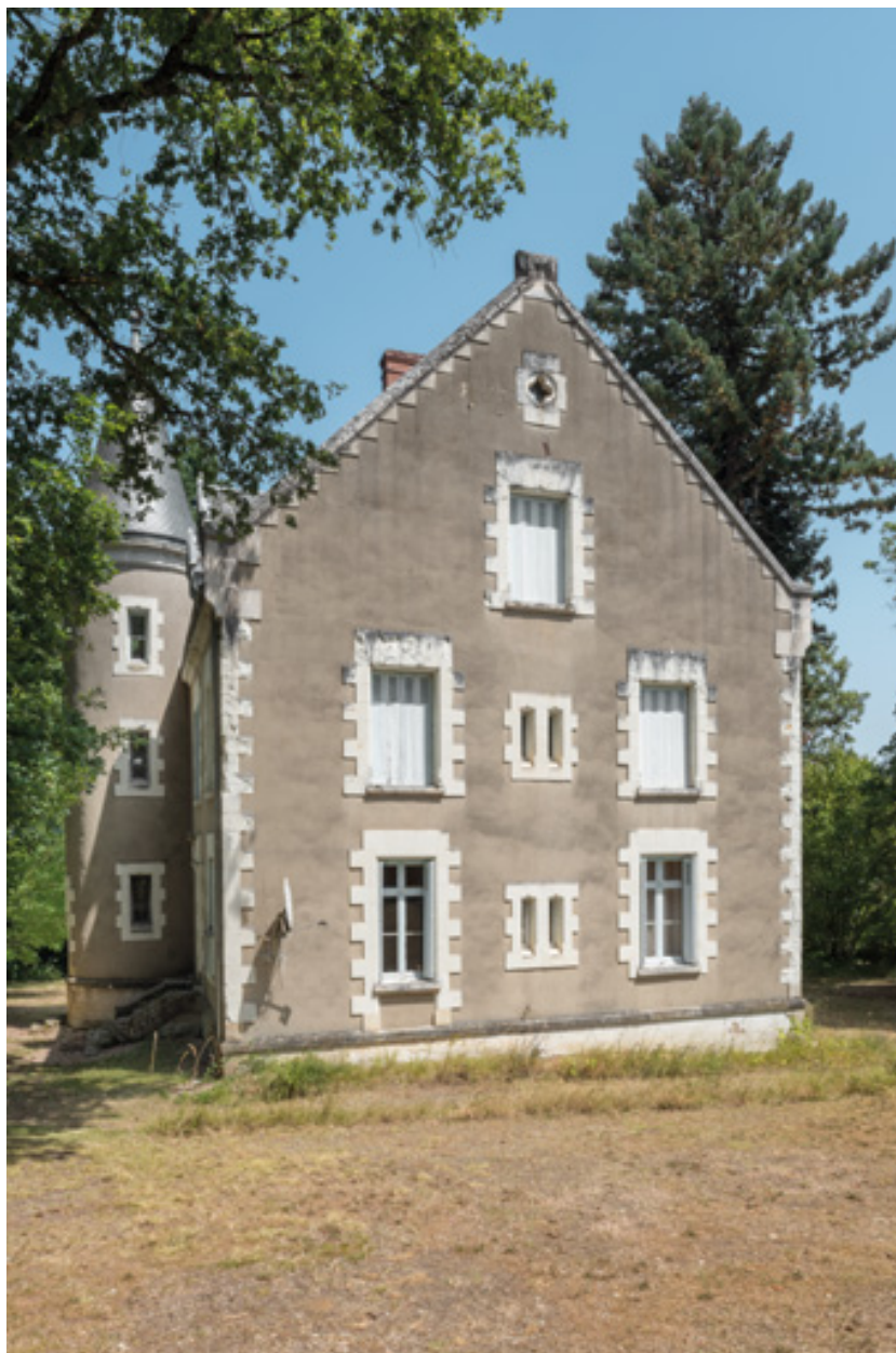
Mur pignon sud-ouest.
