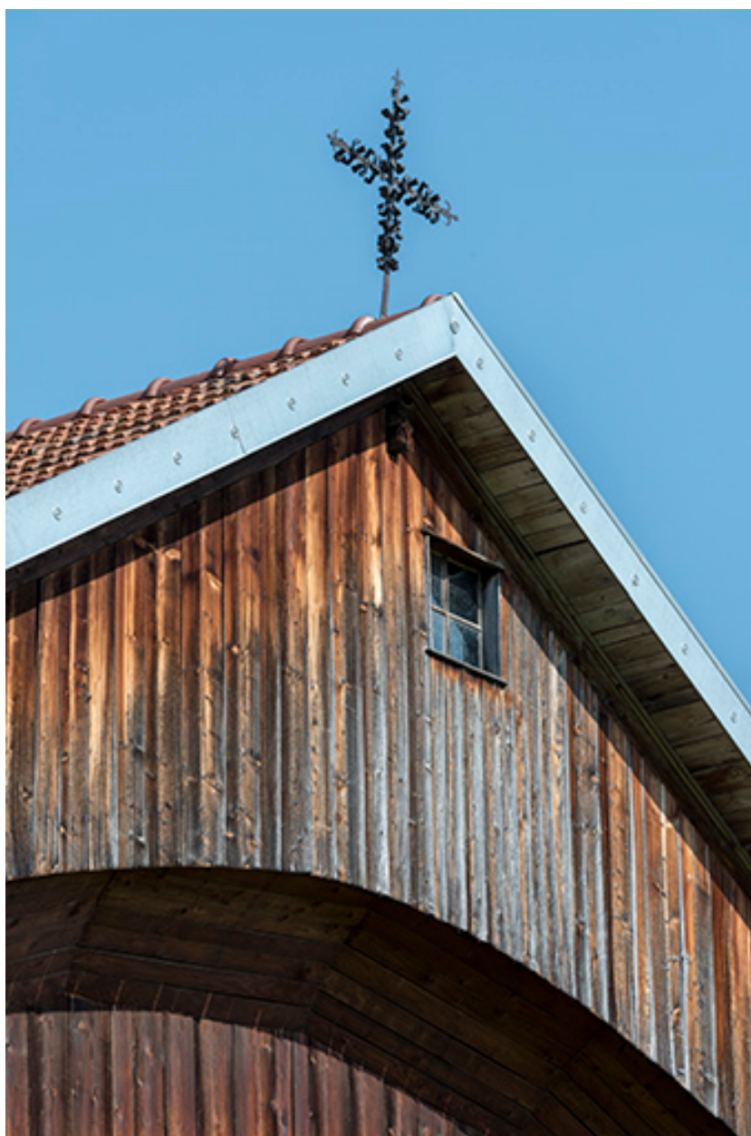
Ferme, façade antérieure : croix de faîtage.
