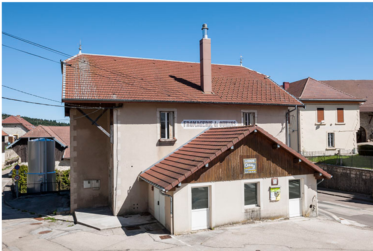
Vue depuis le sud-ouest.
