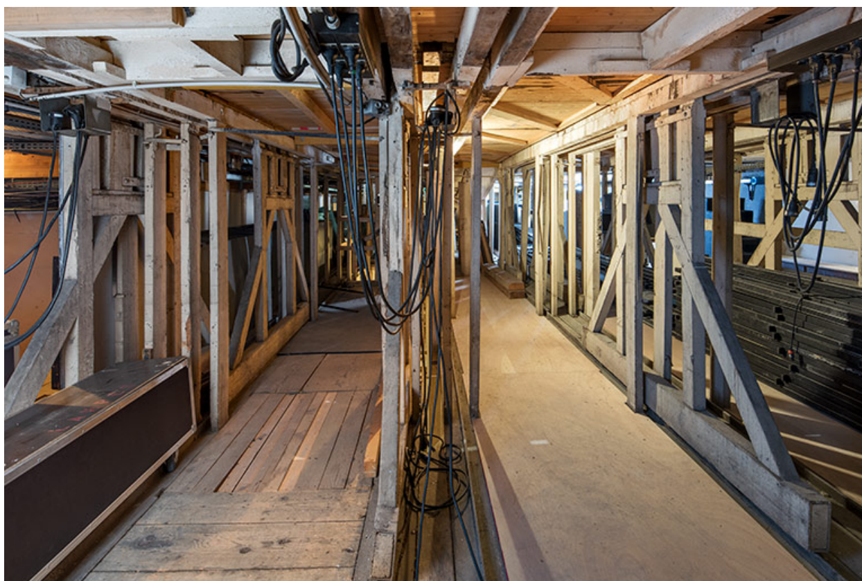
1er dessous : vue d'ensemble frontale, avec chariots de costière.
