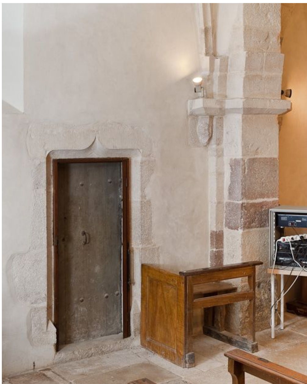
Porte de la tourelle d'escalier.
