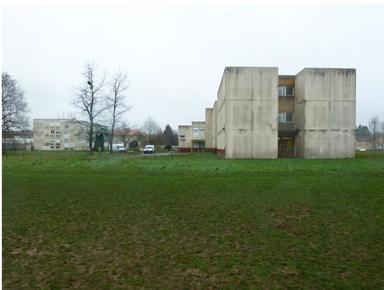
Façade nord de l'internat.
