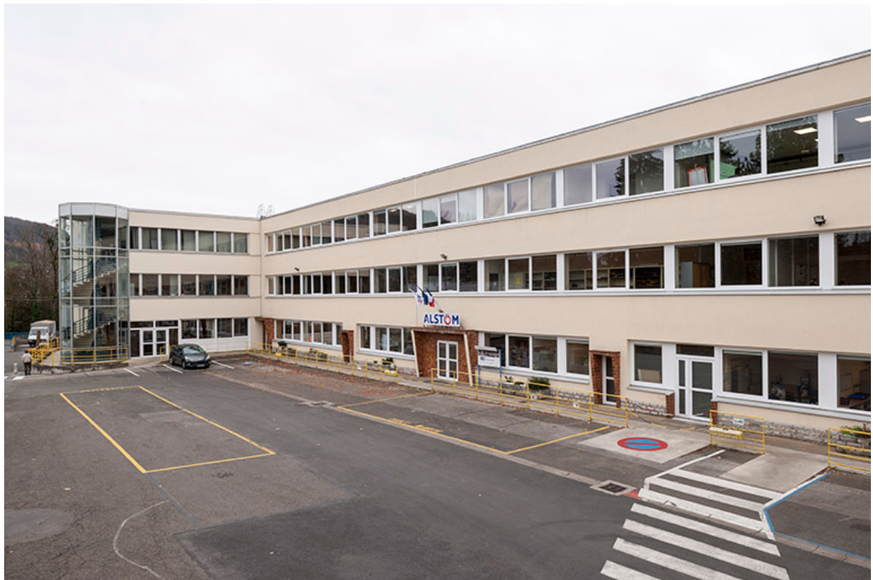
Bâtiment administratif depuis l'entrée.
