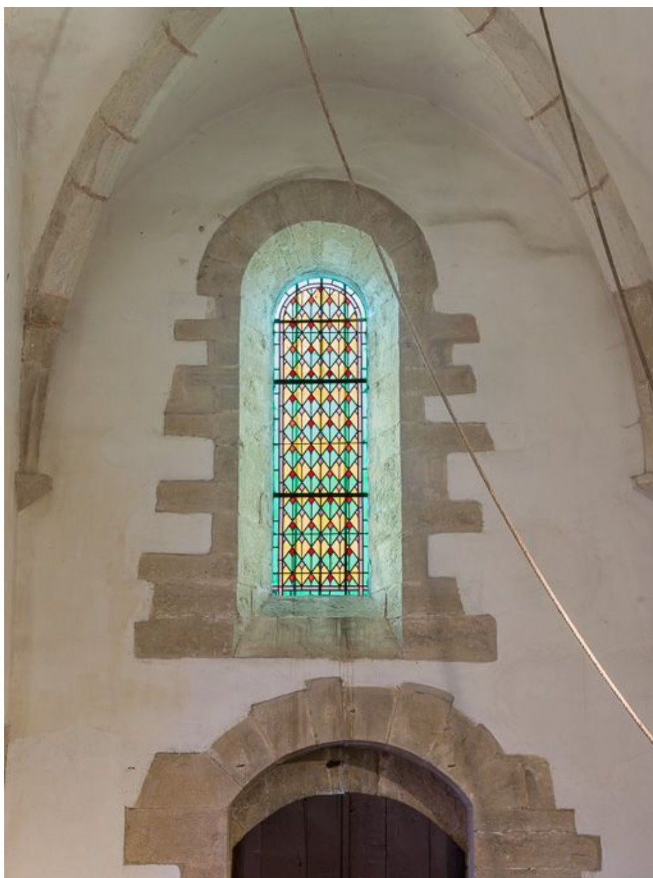
Vue d'ensemble, verrière de la nef.
