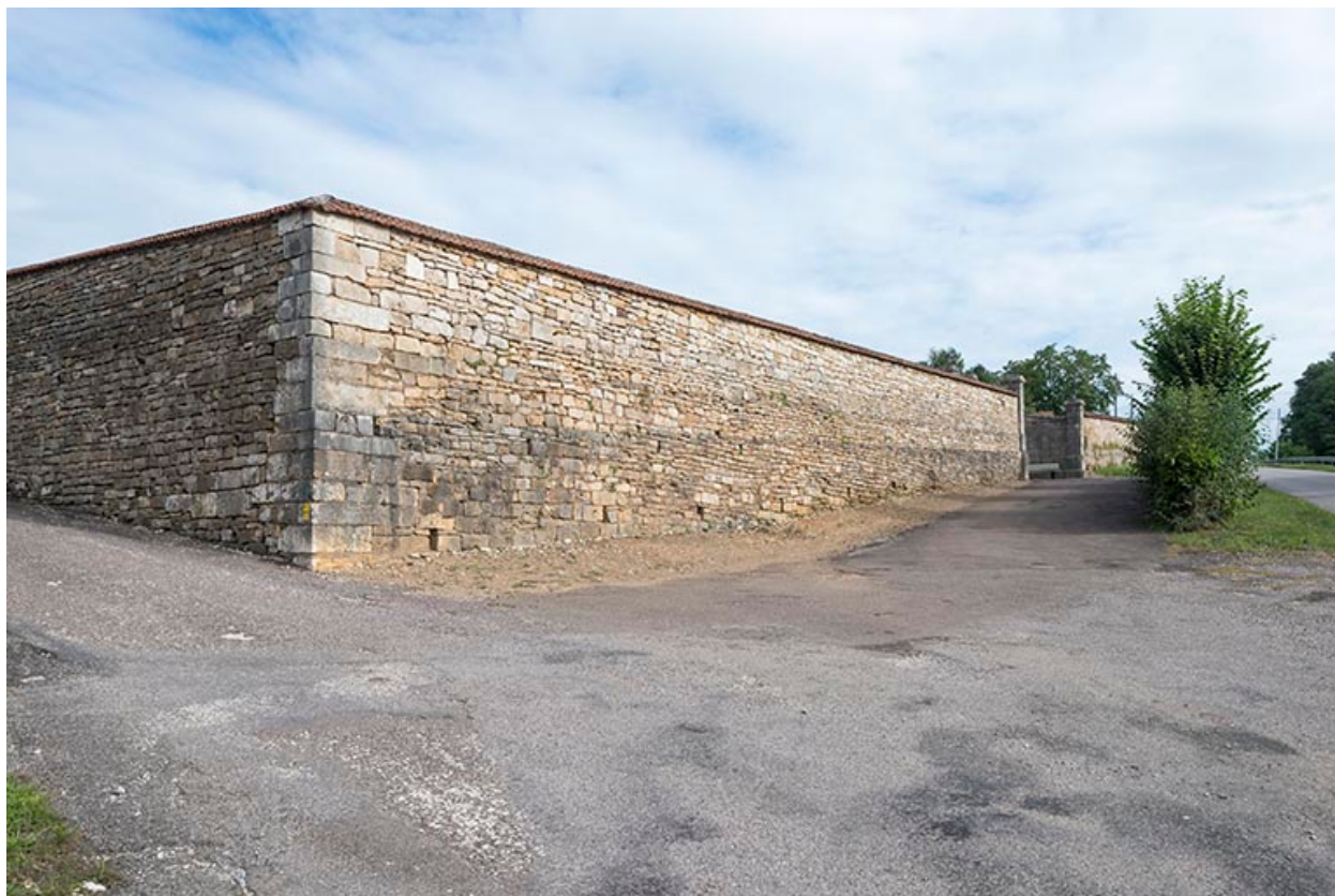
Le mur d'enclos du cimetière.
