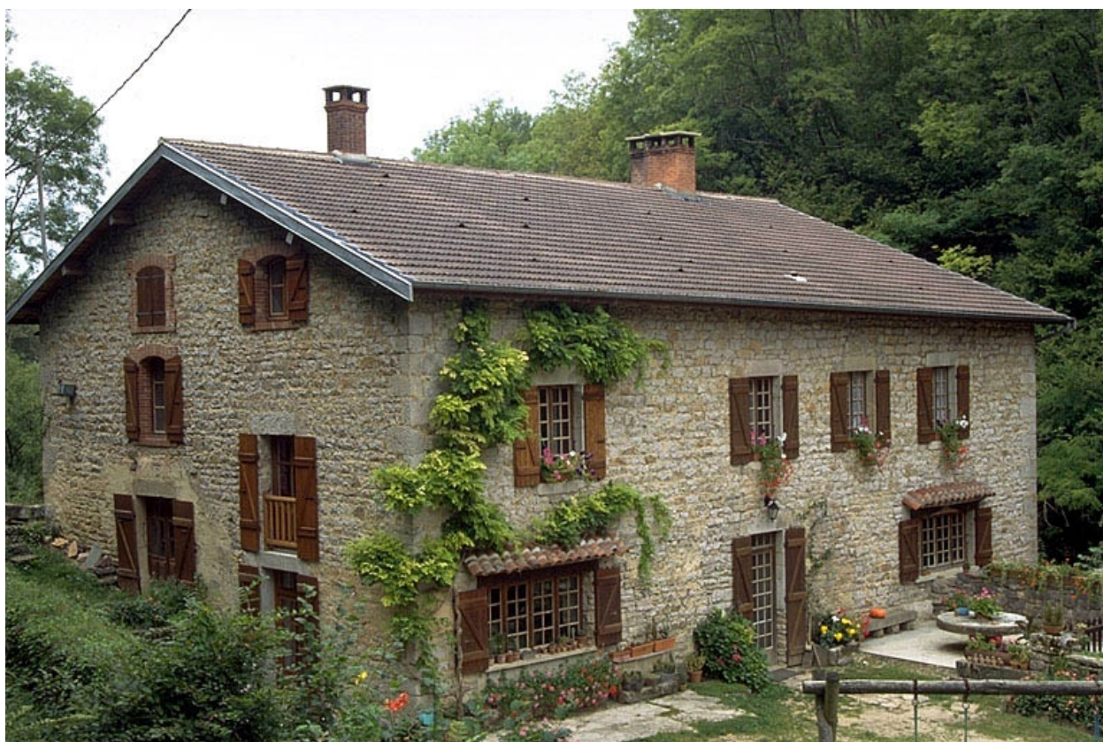
Façades antérieure et latérale gauche.
