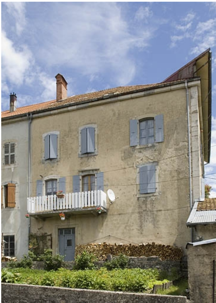
Façade postérieure de la partie sud.
