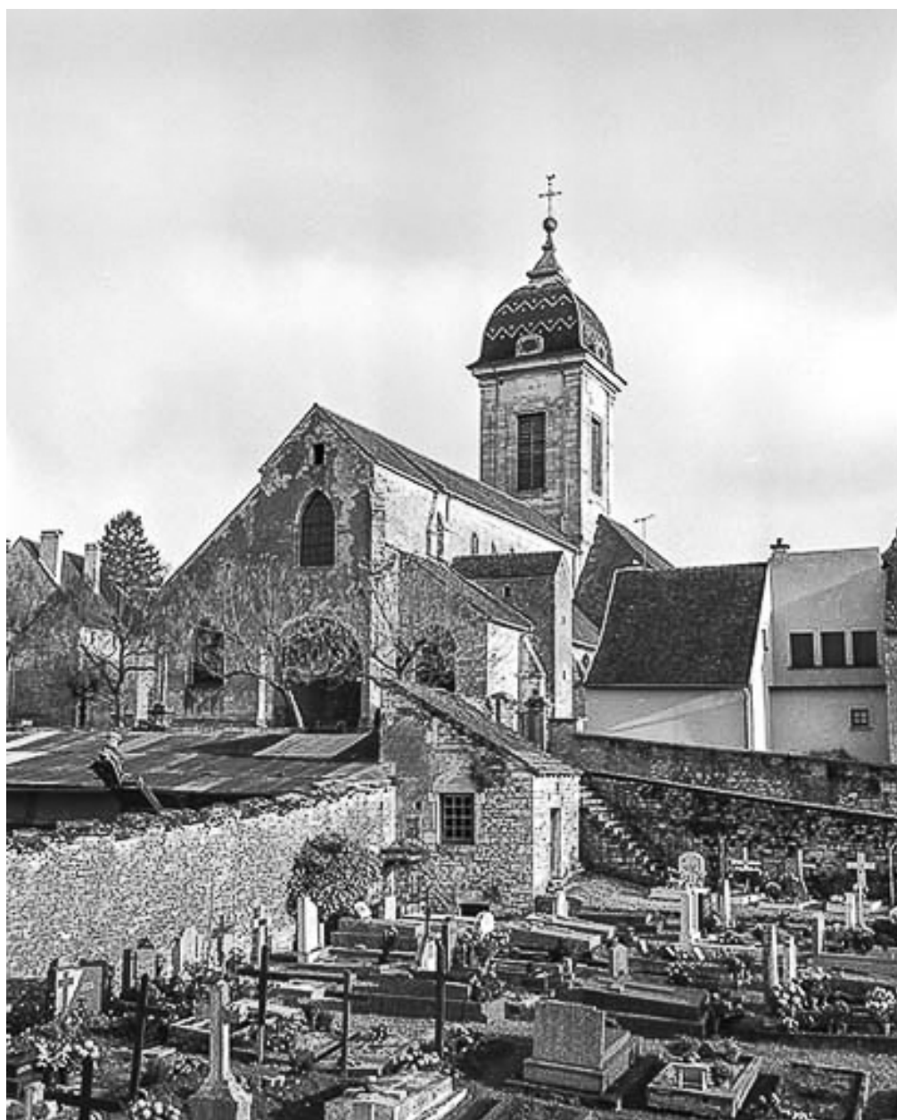
Extérieur : vue d'ensemble depuis le cimetière.
