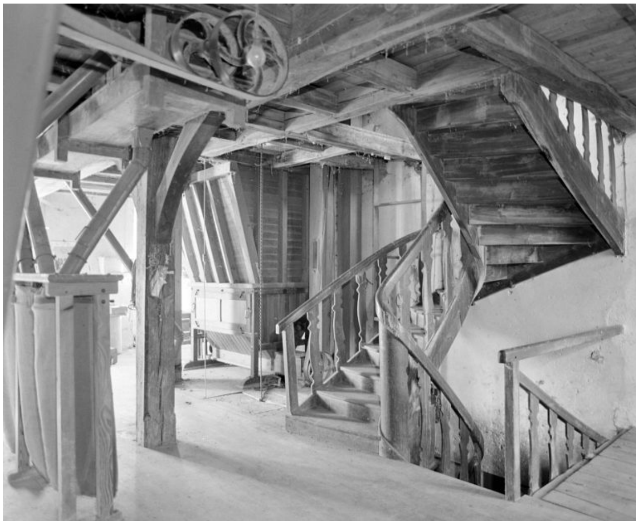
1er étage. Escalier.
