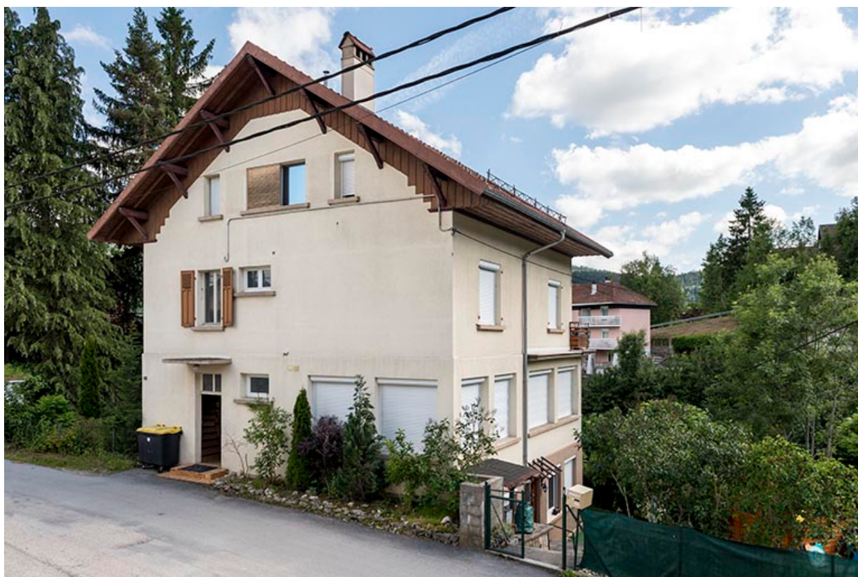
Façades antérieure et latérale droite.
