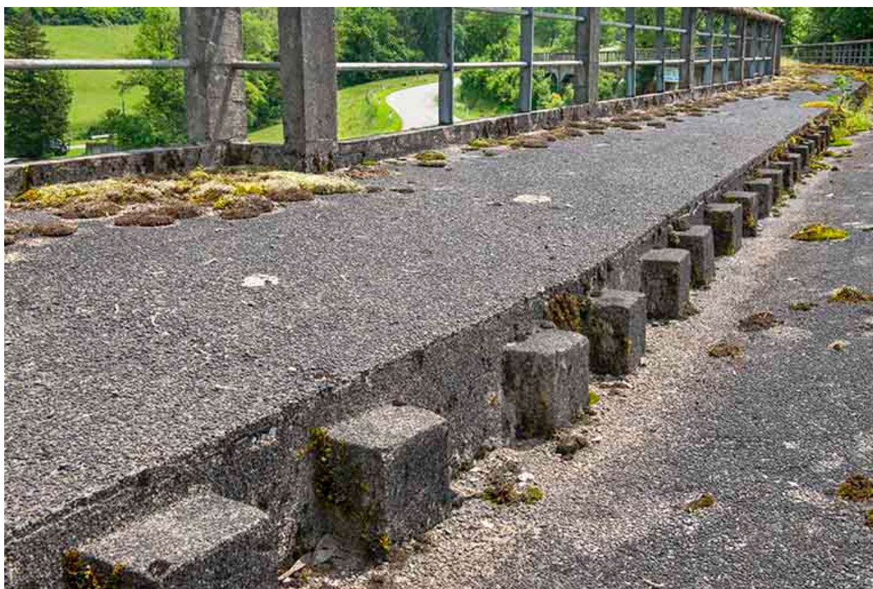
Détail du trottoir et de la chaussée.
