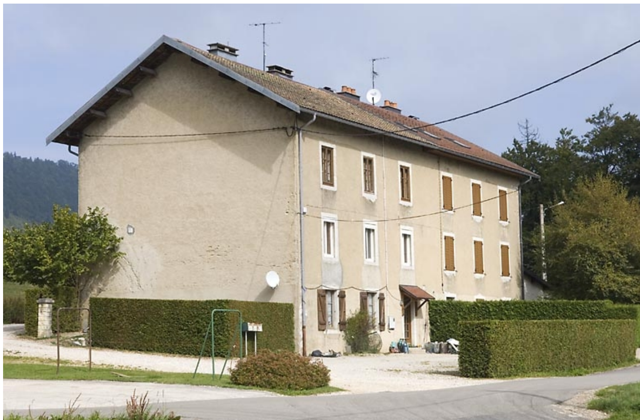
Immeuble de logements, au nord-ouest.
