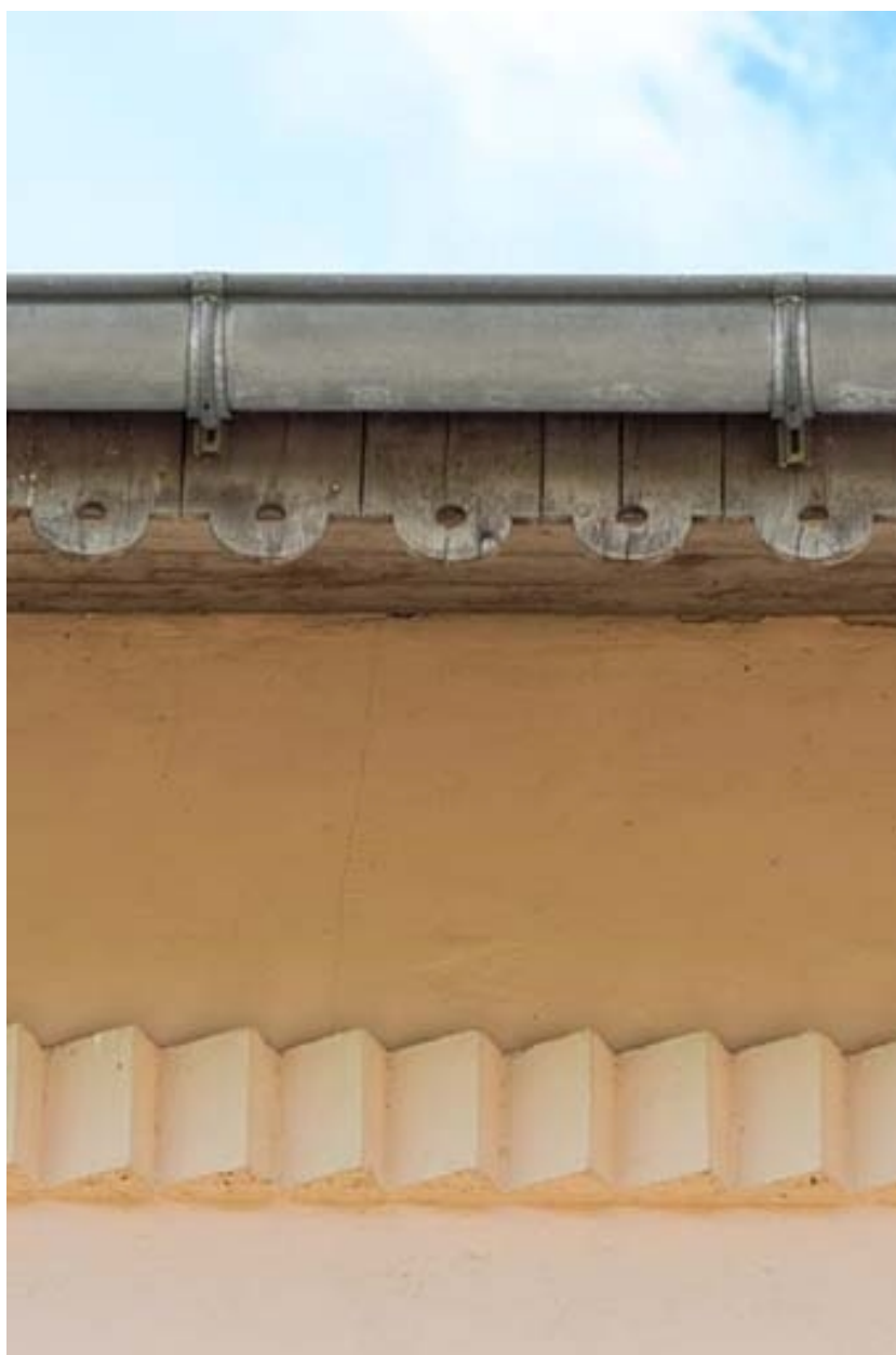
Façade antérieure : décor de briques et lambrequin.
