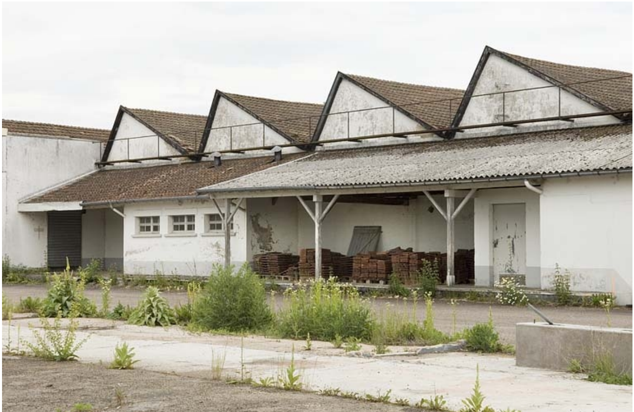
Détail des pignons des sheds de l'atelier de fabrication.
