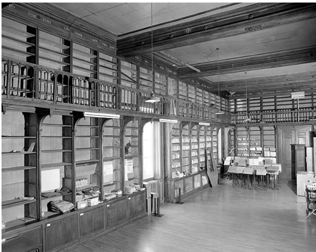
Ancienne salle de la Bibliothèque municipale, détail.
