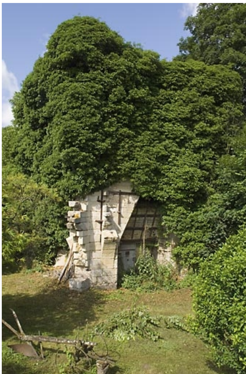
Etat du massif du haut fourneau.
