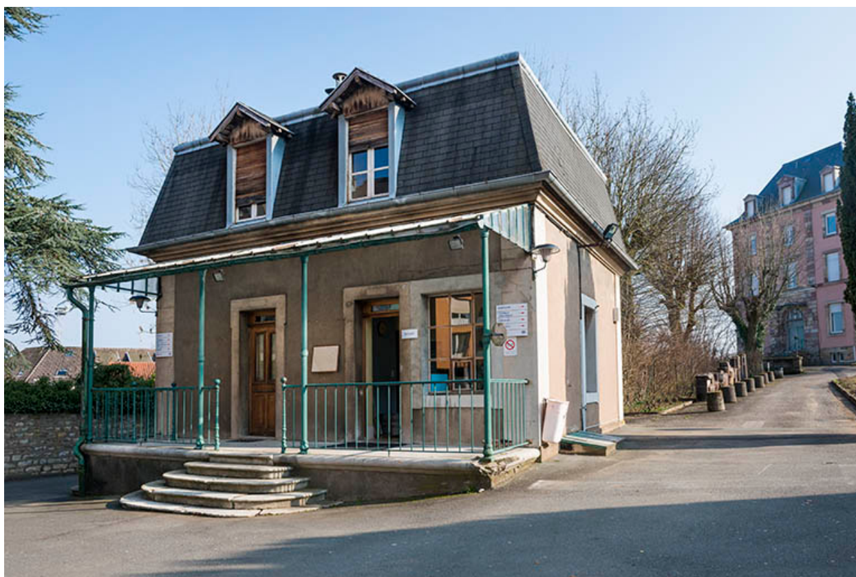
Façade antérieure (nord) de la conciergerie.
