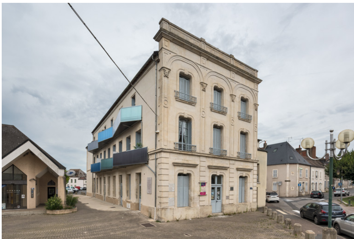
Façades antérieure et latérale gauche.
