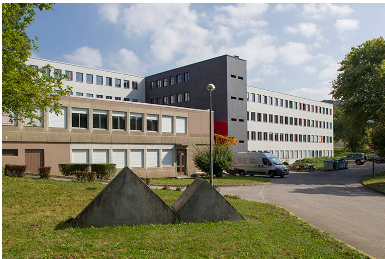
Internat : façade ouest.
