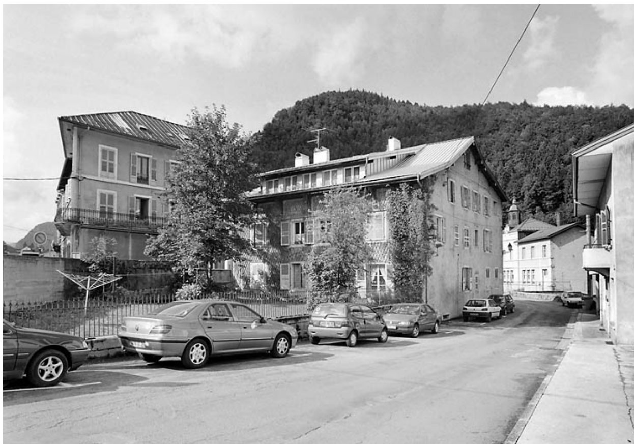
Elévations postérieure et latérale gauche.
