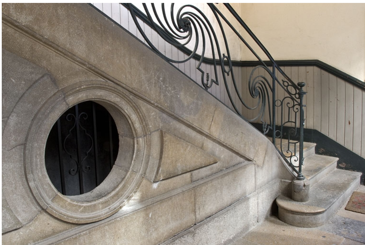
Logis principal : détail du départ de l'escalier.
