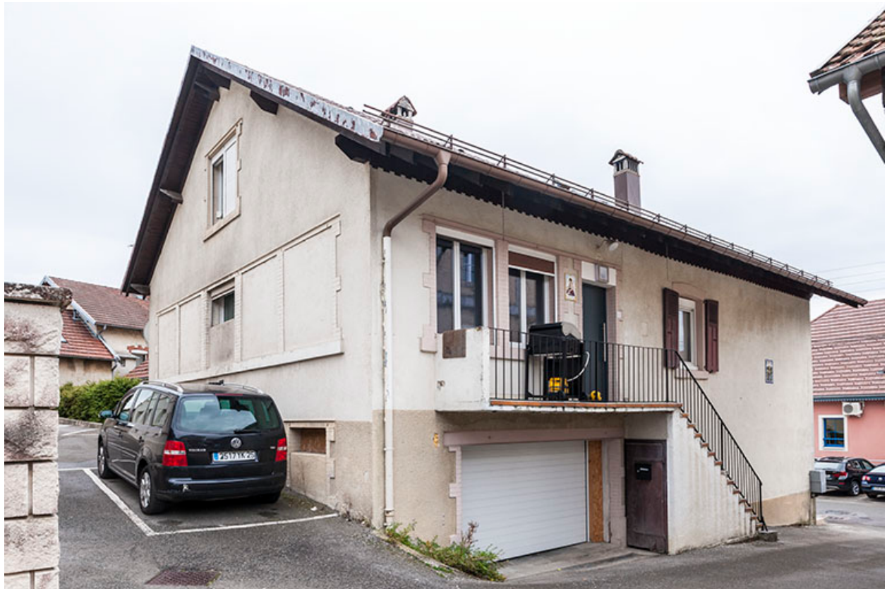
Maison : façades postérieure et latérale gauche.
