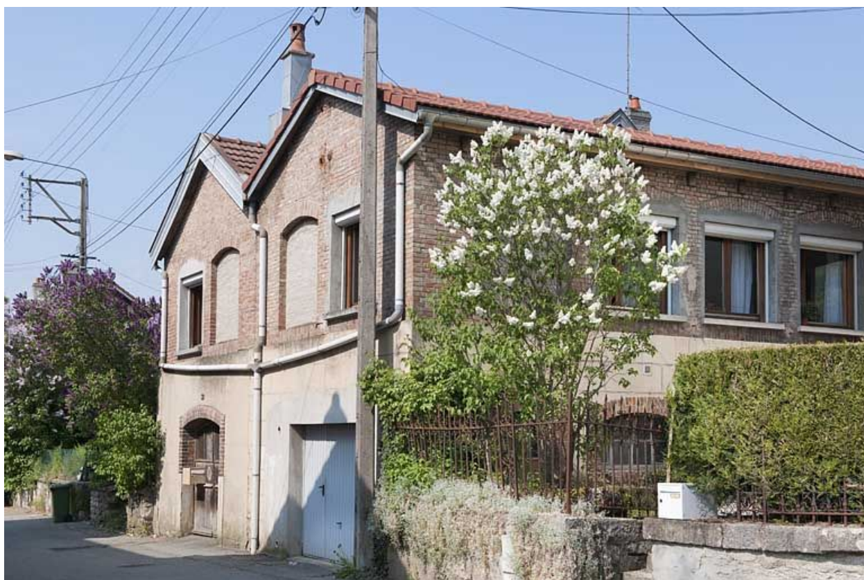
Vue de trois quarts depuis la rue.
