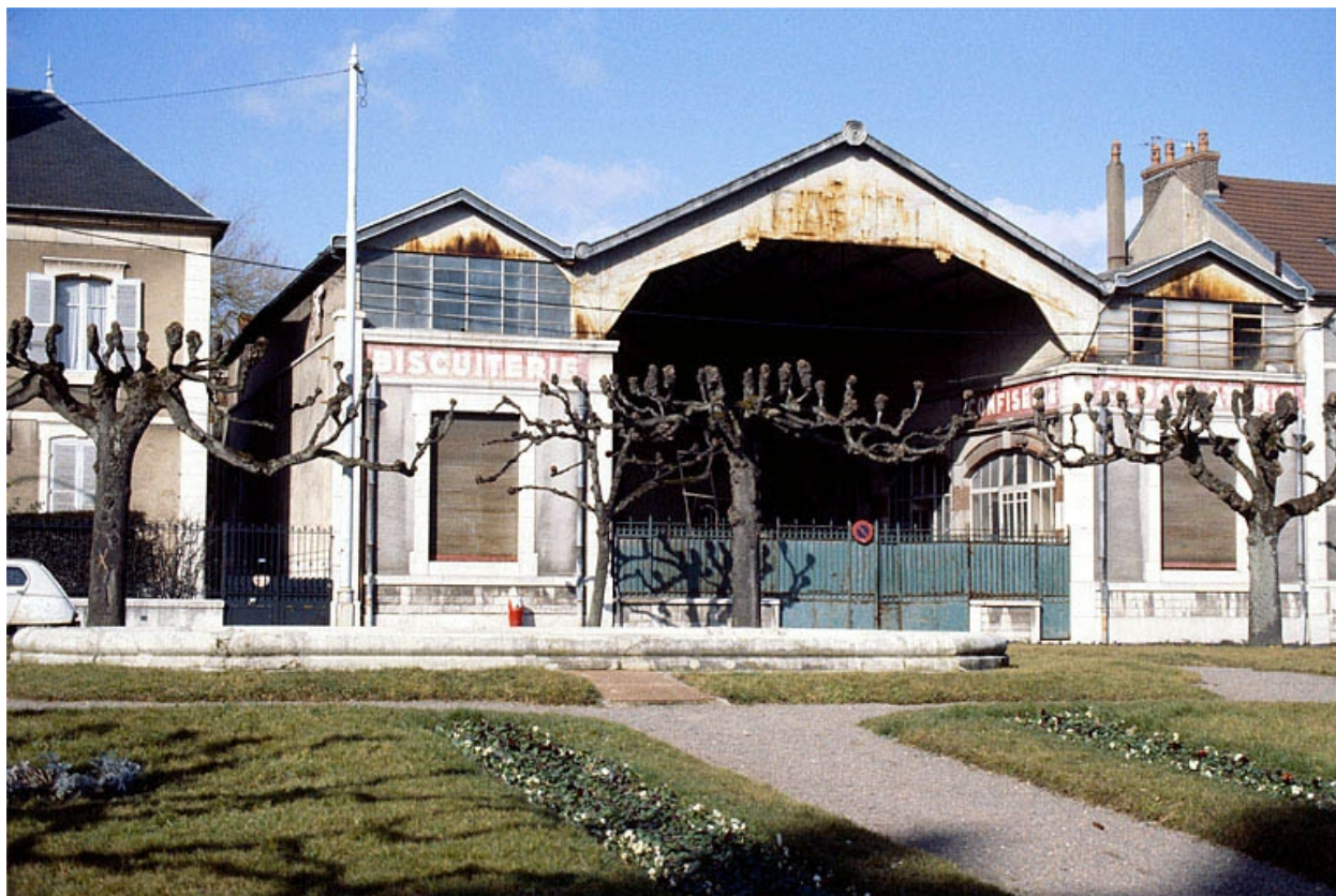
Façade antérieure de l'usine.
