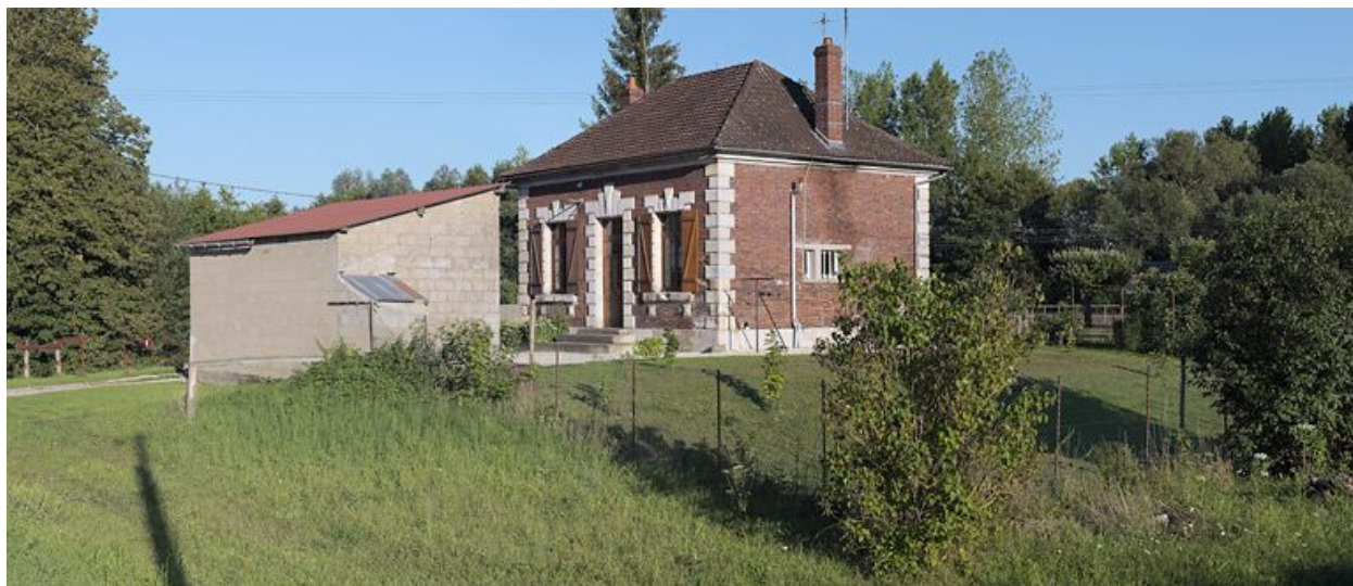
Maison éclusière : 3/4 arrière.
