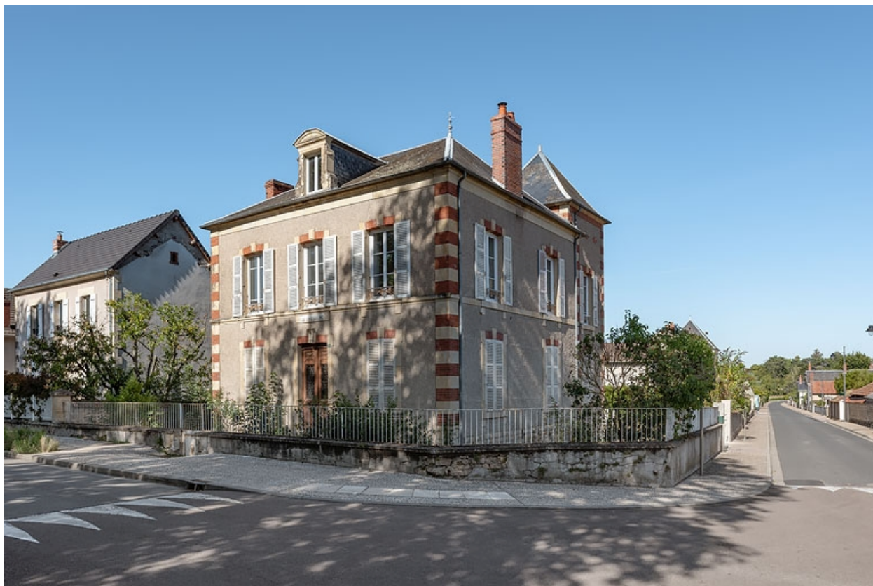
Vue depuis le sud-est.
