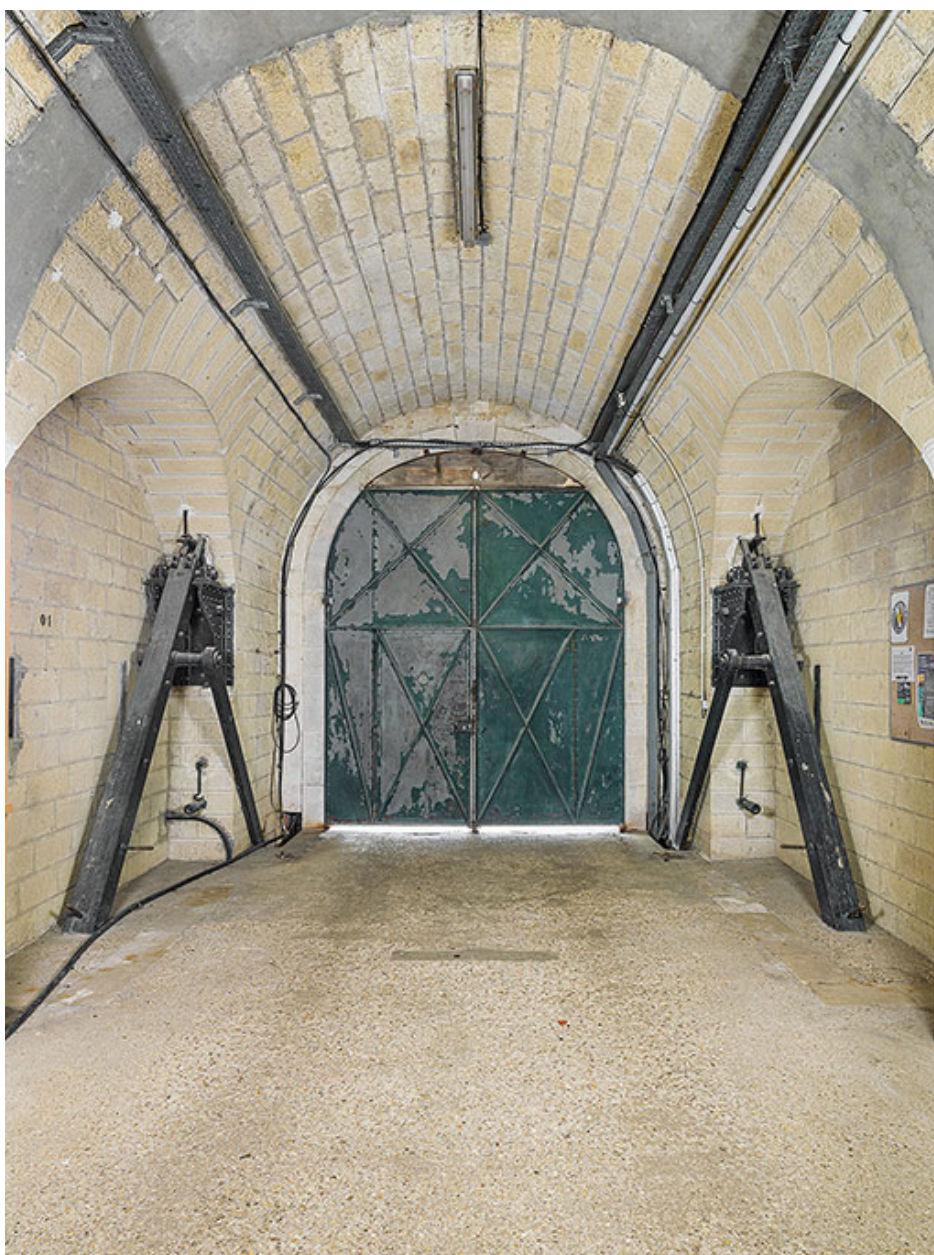
Sas d'entrée du fort, vantaux fermés.
