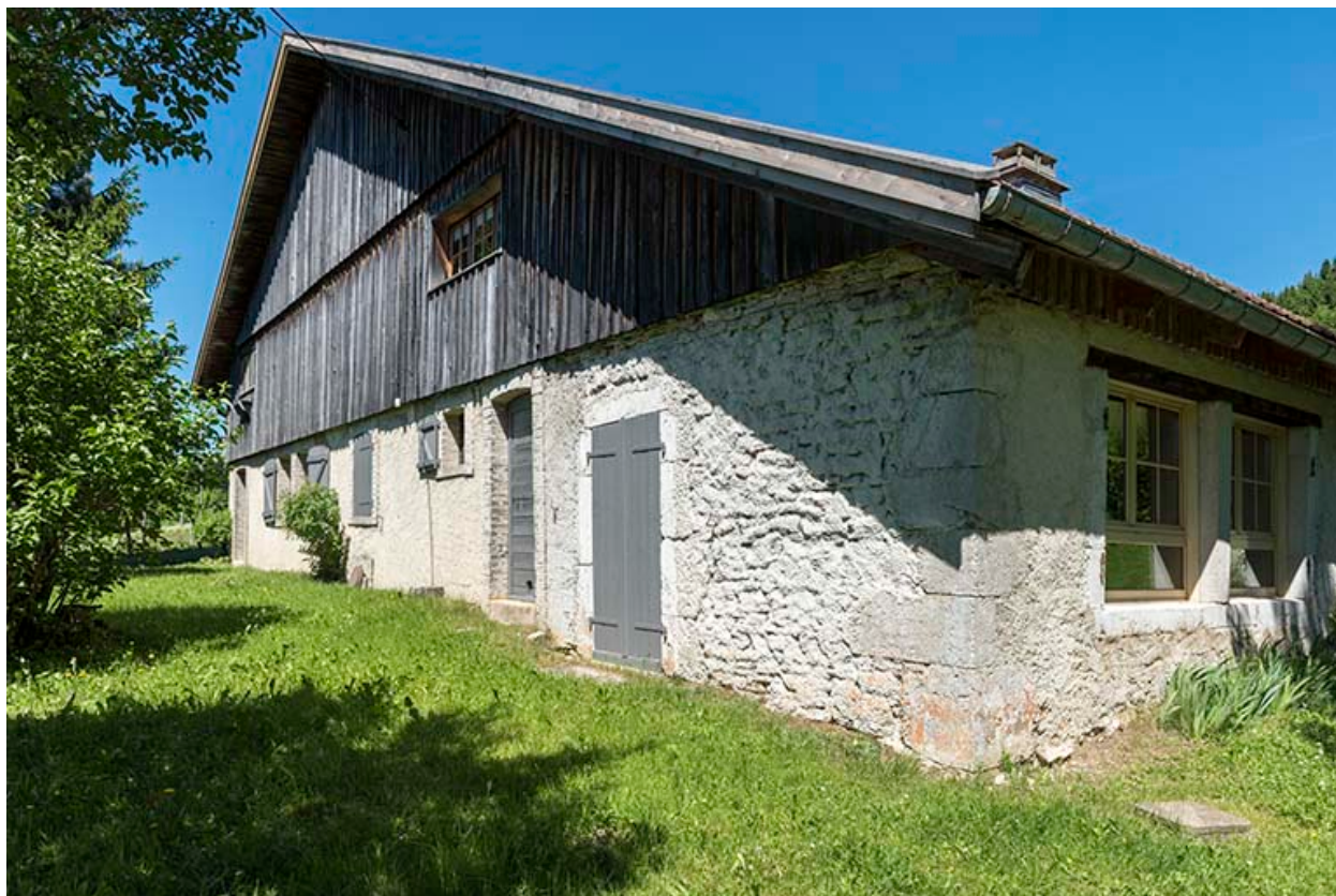
Elévation ouest, vue en enfilade.
