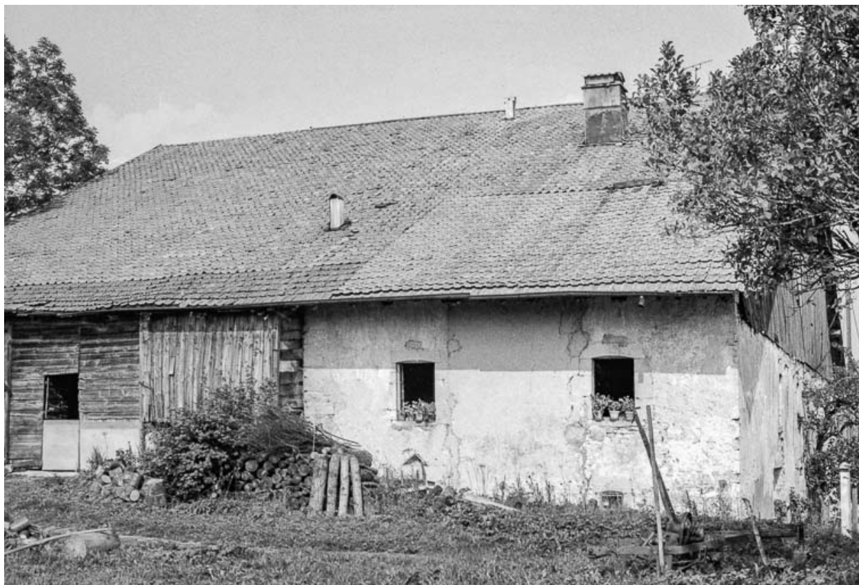
Ferme : façade postérieure.
