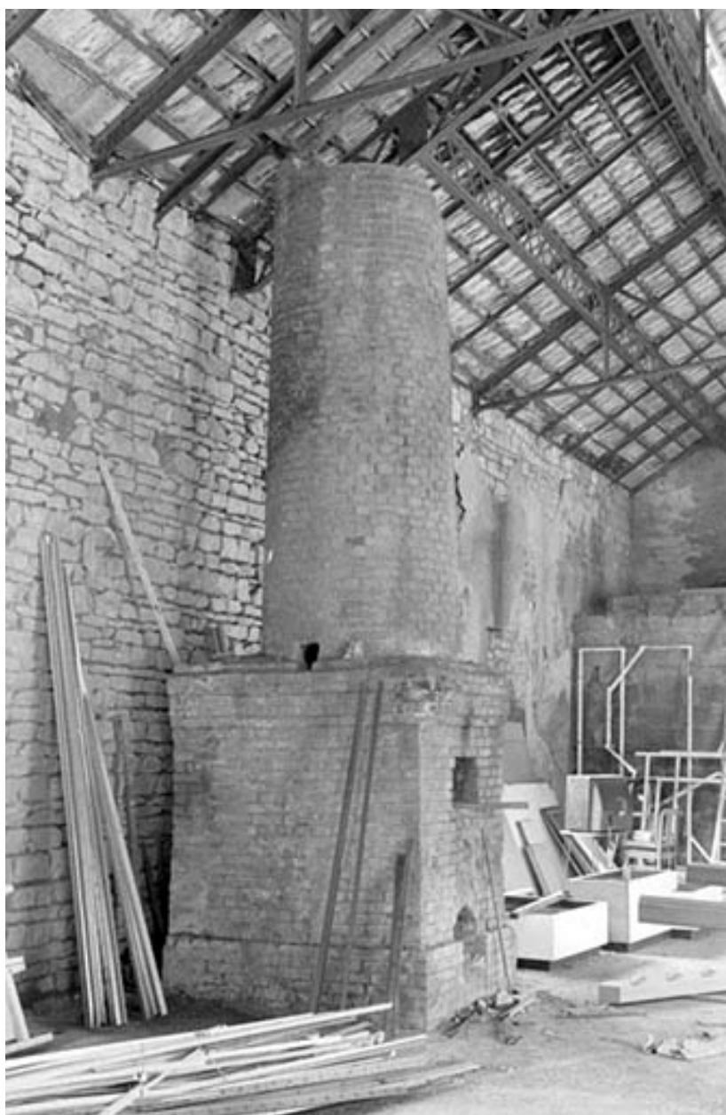
Atelier de réparation, intérieur : base de cheminée.
