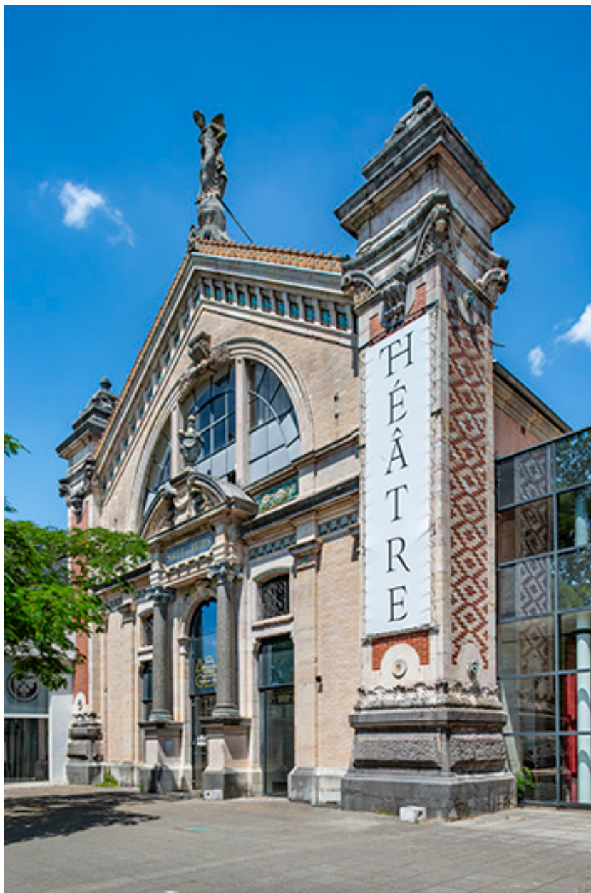
Façade principale, vue de trois quarts.
