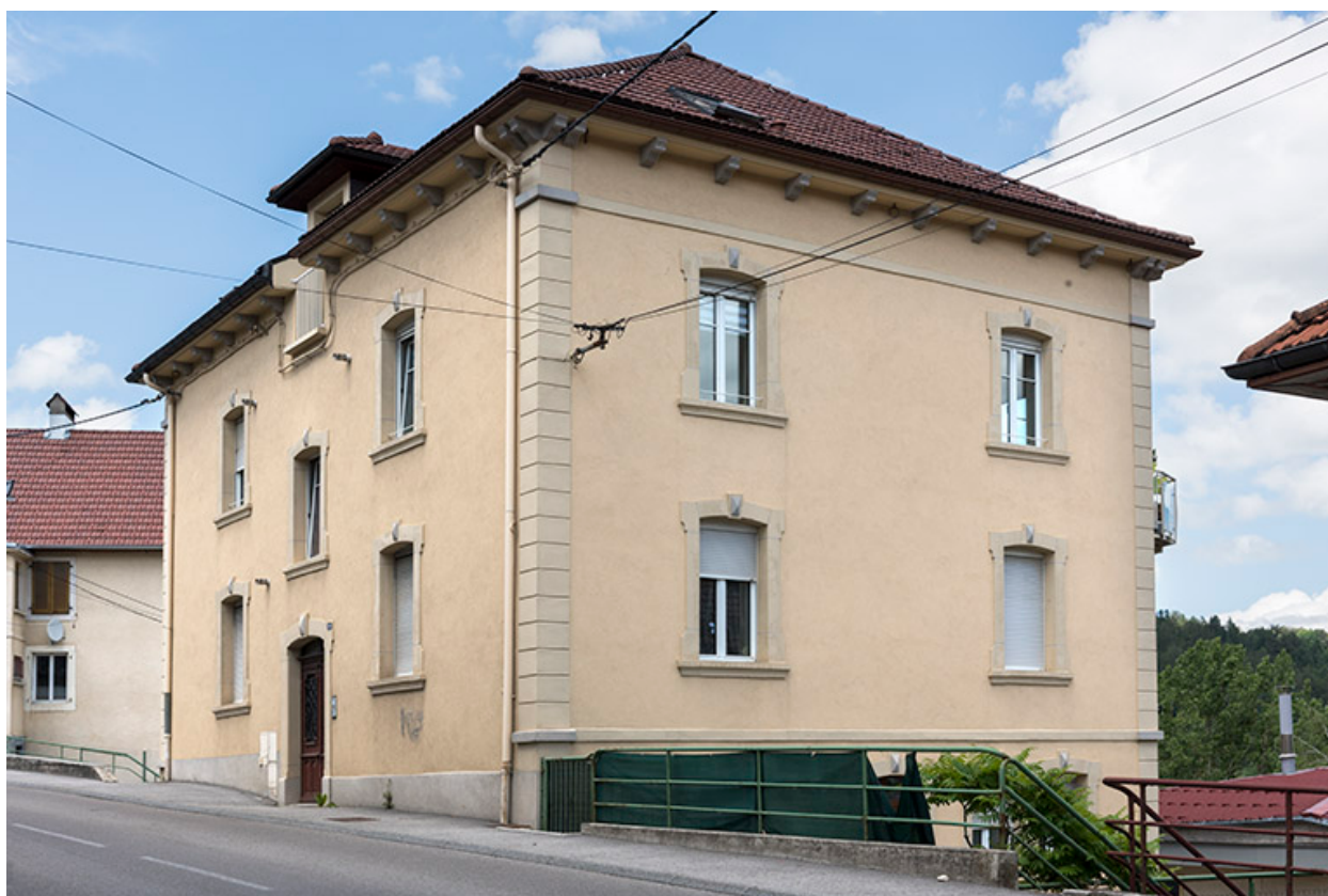
Façades antérieure et latérale droite.
