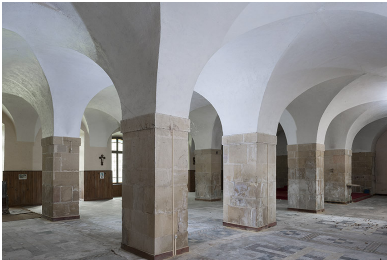
Intérieur : l'étage de soubassement.
