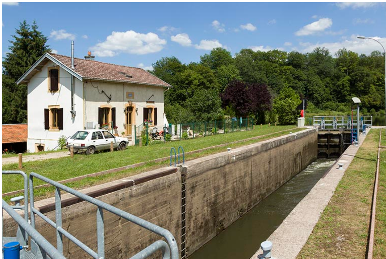
Le site d'écluse, depuis l'aval.
