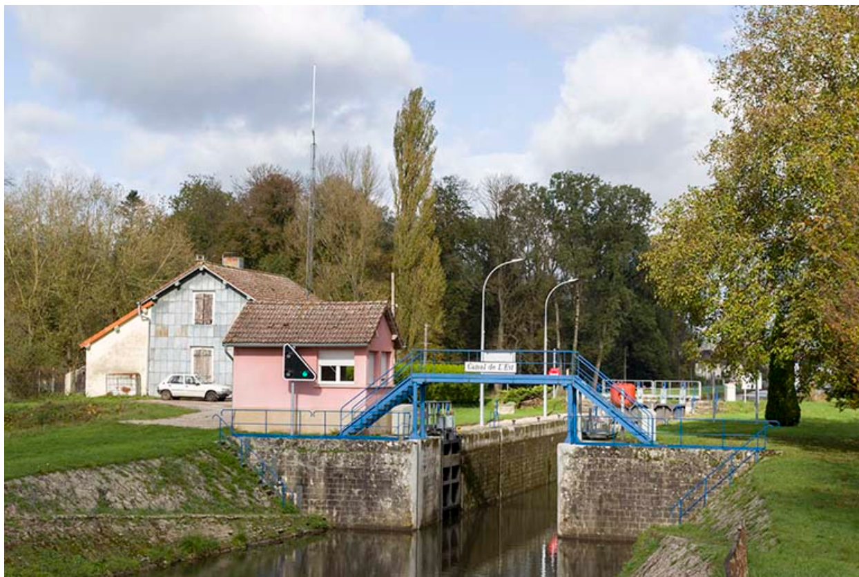
Vue du site d'écluse depuis l'aval.
