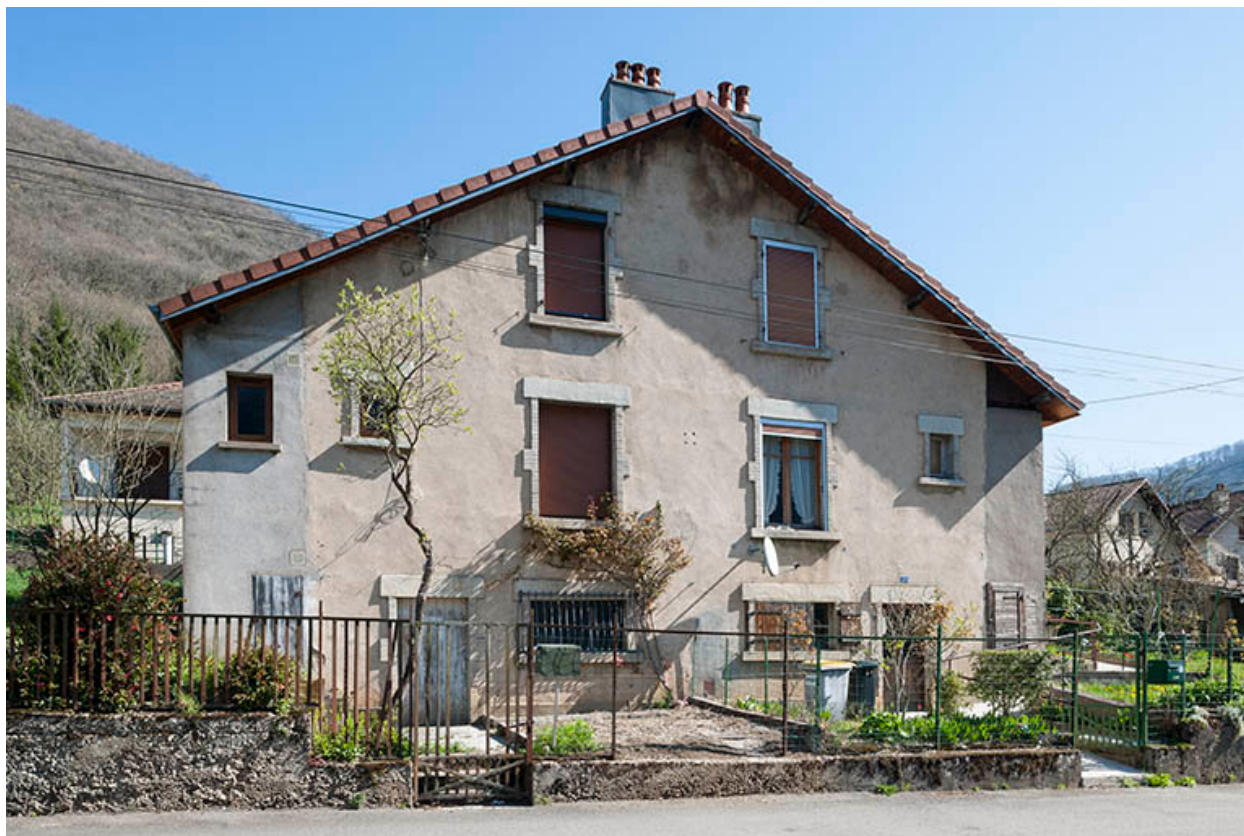
Façade antérieure d'une maison jumelée.
