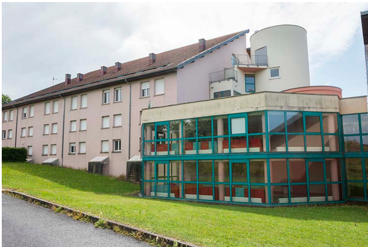
Façades postérieures nord de l'internat nord-est.
